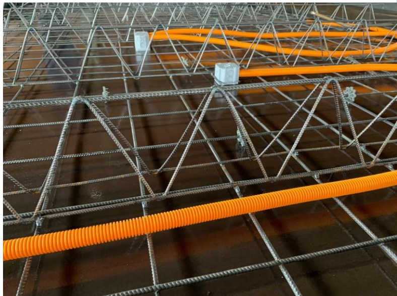
Shtrirja e instalimeve dhe pregatitja e murit për betonim
