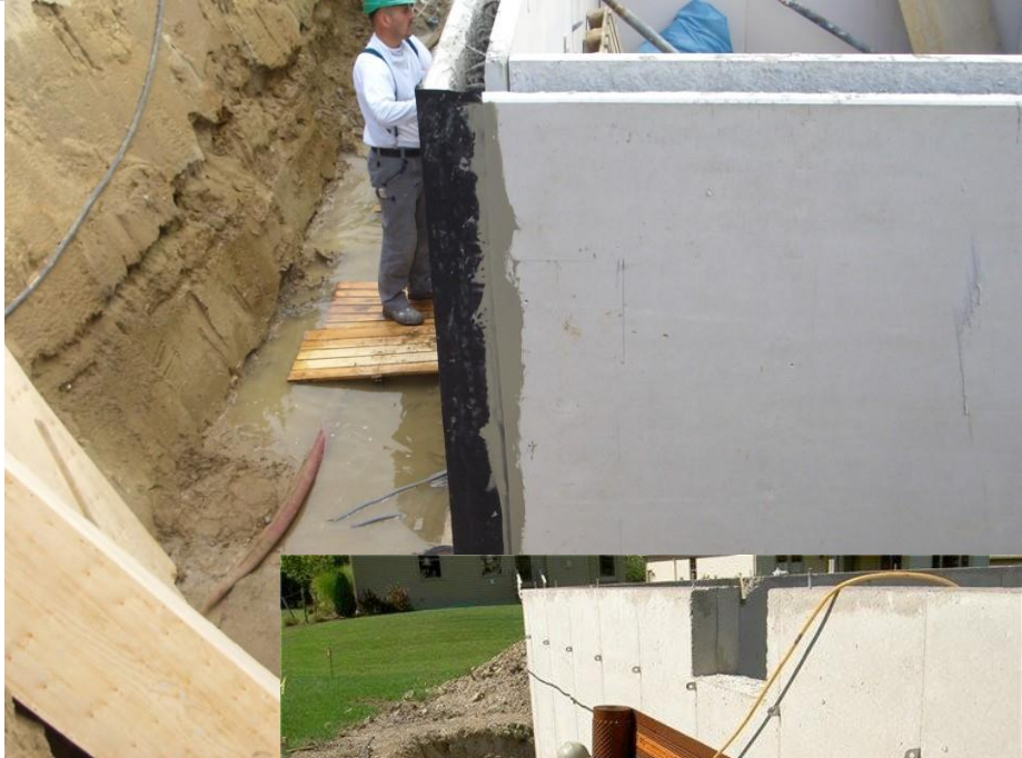
Punimi i hidroizolimit
